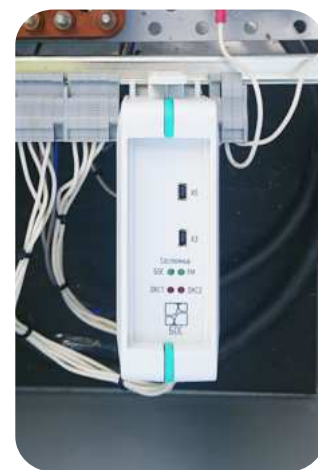
Блок обработки сигналов БОС
