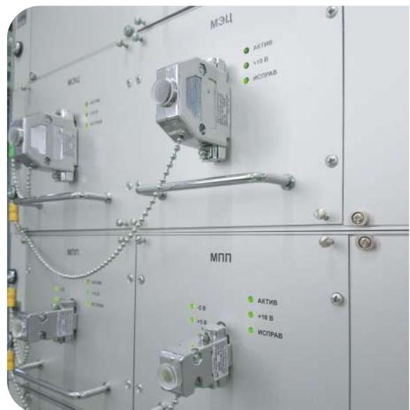
Аппаратура АБТЦ-И выполнена на современной высокопроизводительной микропроцессорной элементной базе без применения электромагнитных реле. В зависимости от требований заказчика в АБТЦ-И реализуются алгоритмы автоблокировки со светофорной 3-значной и 4-значной сигнализацией, автоматической локомотивной сигнализации как самостоятельного средства интервального регулирования (АЛСО), а также системы интервального регулирования с подвижными блок-участками.
