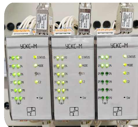
Устройство сопряжения с каналами связи УСКС-М
