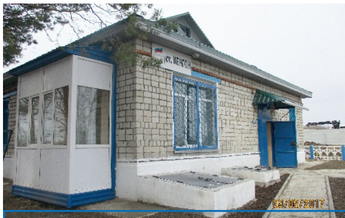
Оборудование сотовой станции системой МПЦ-И – станция Менгон Дальневосточной железной дороги.
