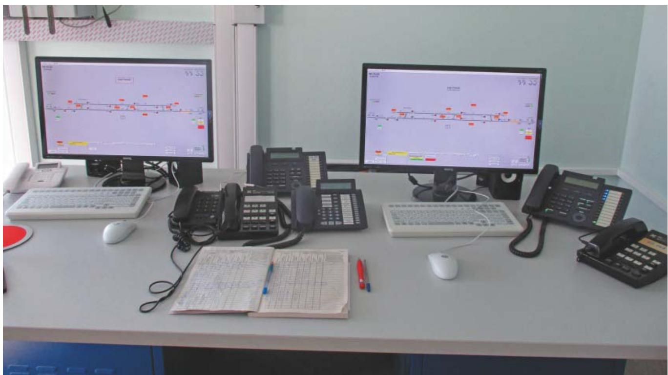
В июле завершилось оборудование системой МПЦ-И ст. Хуту Высокогорненской дистанции СЦБ. На станции система контролирует работу 6 стрелок и 11 светофоров. Была выполнена увязка с системой диспетчерской централизации «Тракт», а также с системой диагностики технических средств железнодорожной автоматики и телемеханики на перегонах СДТС-АПС, дежурный по станции видит состояние перегона Хуту-Дайчи.
