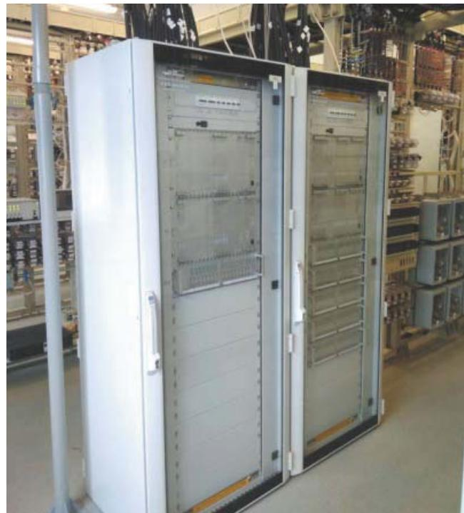
Для повышения надежности работы устройства электрической централизации пять приемо-отправочных путей на станции оборудованы устройствами ЭССО-М, которые работают совместно с тональными рельсовыми цепями – здесь реализован вариант комбинированного применения системы счета осей. На остальных путях и стрелочных секциях станции ЭССО-М выполняет функции основного средства контроля свободности путевых участков.
