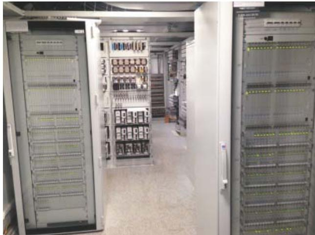
В конце весны завершились пусконаладочные работы на Разъезде 303 км Комсомольской дистанции СЦБ. На объекте микропроцессорная централизация стрелок и сигналов МПЦ-И управляет 9 стрелками и 12 светофорами, в состав системы входит резервированный управляющий контроллер централизации УКЦ. На станции установлена система гарантированного питания микрэлектронных систем СГП-МС, впервые применена расширенная диагностика устройств беспере-
