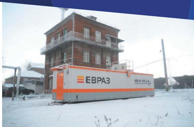
рабочее место электромеханика АРМ ШН размещены в мобильном контейнерном модуле МКМ производства НПЦ «Промэлектроника», а рабочее место диспетчера маневрового АРМ ДСП находится в здании поста ЭЦ.
