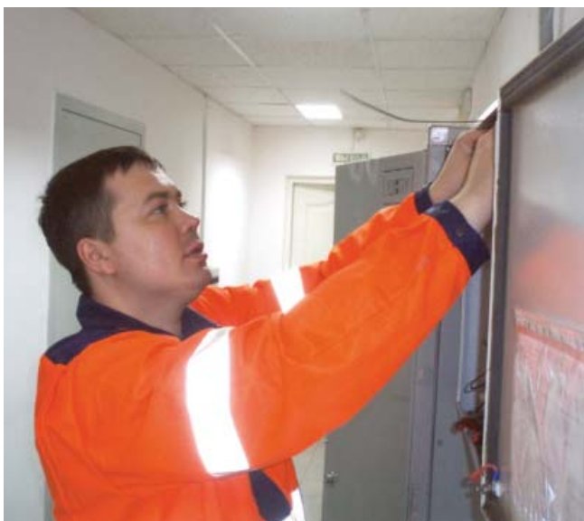
Участие в пусконаладочных работах на ст. Асфальтная (2005)
