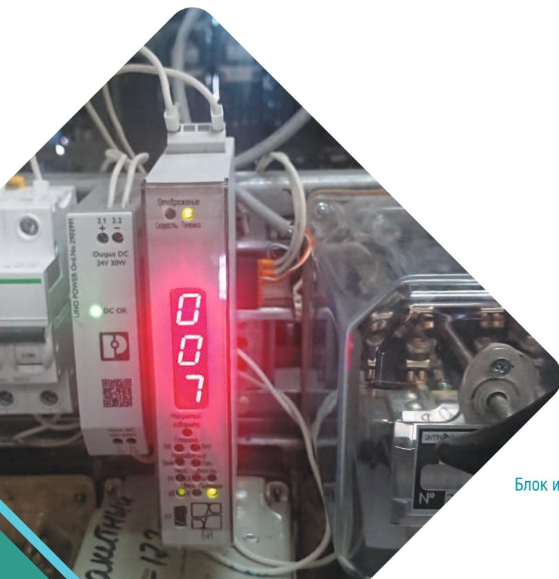
При работе в штатном режиме БУКС фиксирует номера тележек, а также направление движения подвижного состава и его скорость. Информация отображается на индикаторах БИ и передается в системы верхнего уровня.
