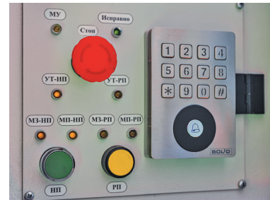
Пульт местного управления устанавливается в междупутье в непосредственной близости от тормозного упора
