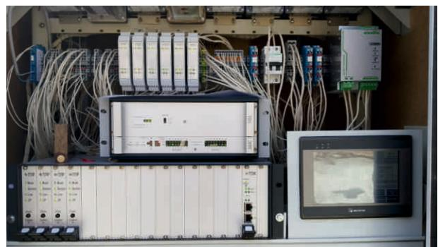
ООО «УГМК-Холдинг», железнодорожная инфраструктура ОАО «СУМЗ». Для увеличения пропускной способности станции, расположенной на расстоянии более 8 км, с помощью ББК-02 организовано удаленное управление и контроль по ВОЛС за ЭССО-М, стрелочными приводами и светофорами.
