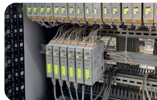
Постовое оборудование системы ЭССО-ИЛС
