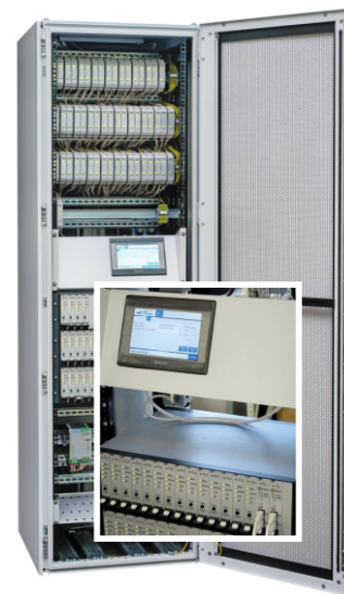
Постовое оборудование ЭССО-М-2
