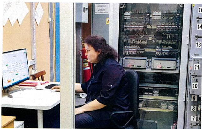
Пусконаладочные работы на станции Нижнесергинская
