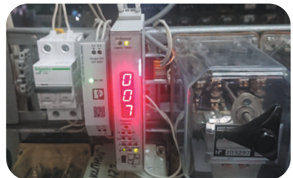
BI Interfacing Unit
